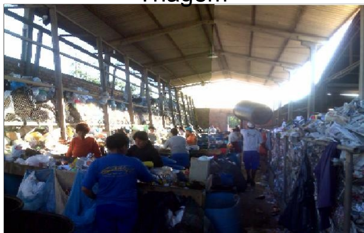
Construção de Galpões de Triagem
