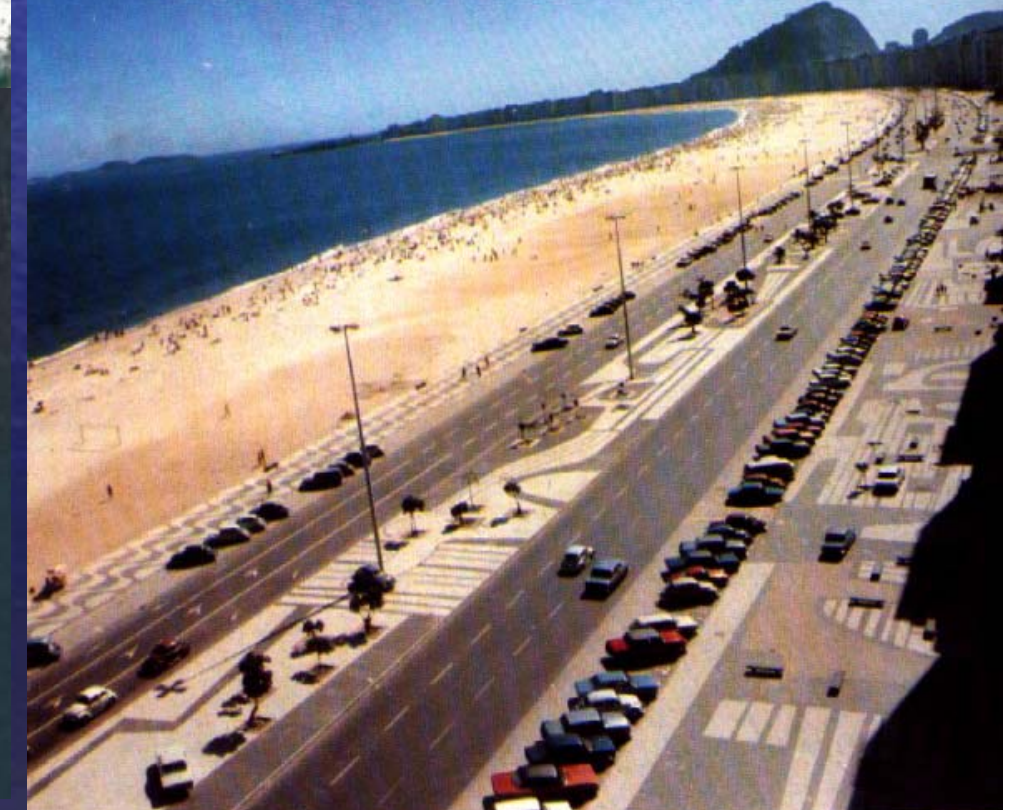
Obra flexível de alimentação artificial de areia na Praia de Copacabana (RJ) (1970)
