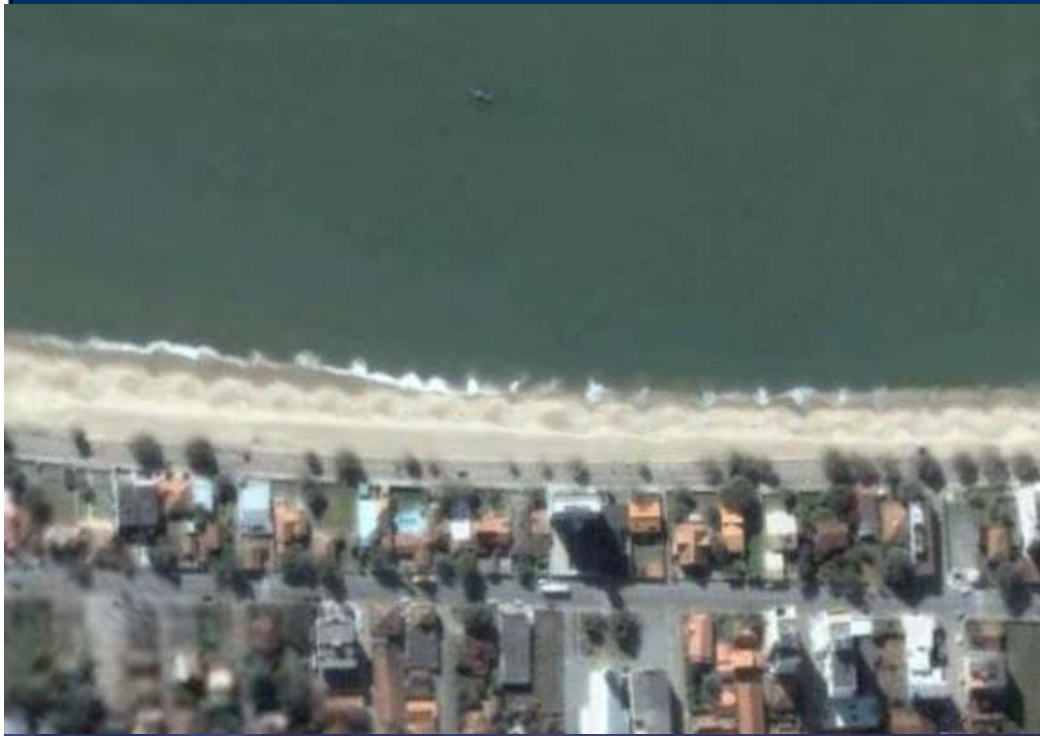
Obra flexível de alimentação artificial de areia em Piçarras (SC) (1998 – 2002)
