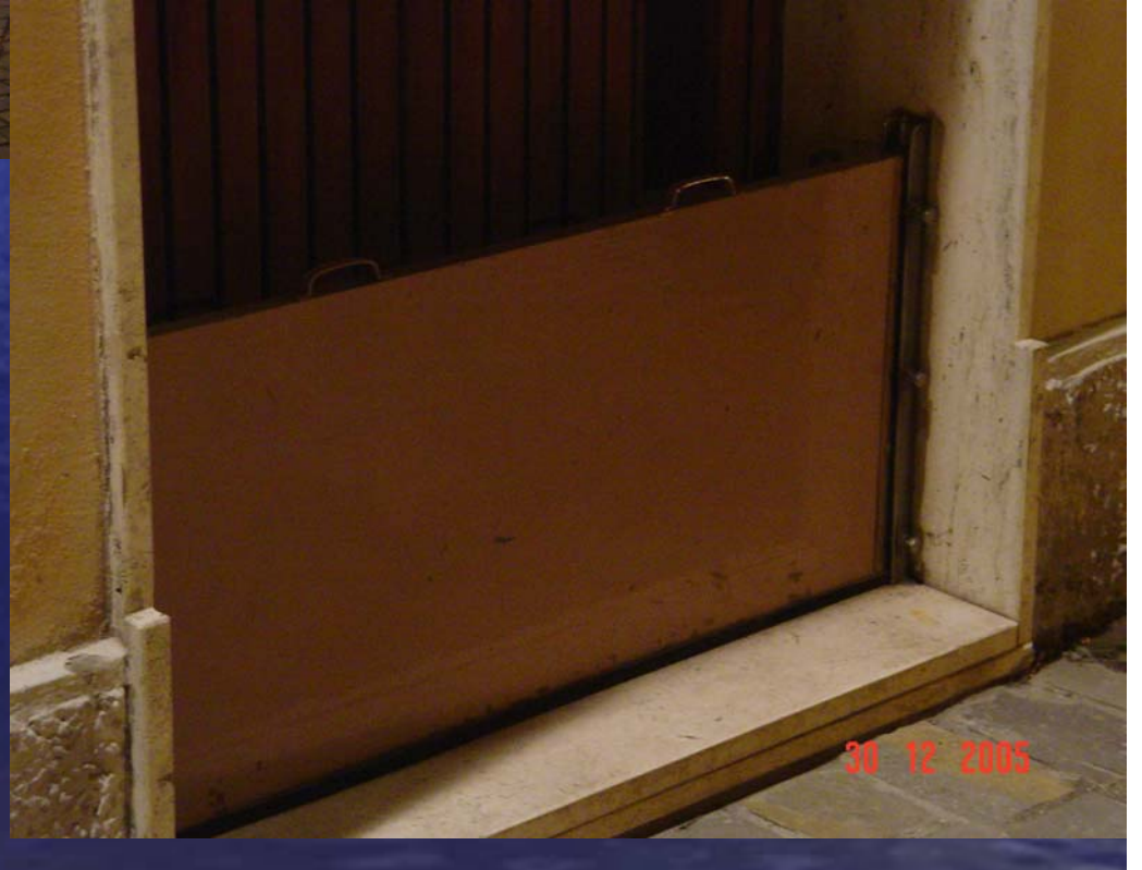
Comportas stop-log planas nas portas das construções junto ao canal em Cesenatico
