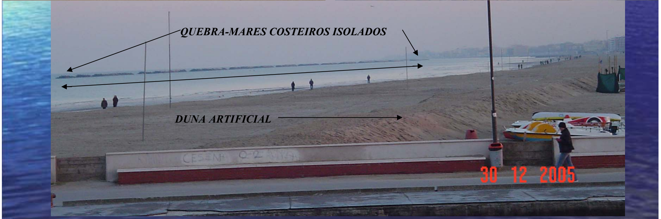
Múltiplas obras de defesa dos litorais em Cesenatico no Mar Adriatico na Italia
