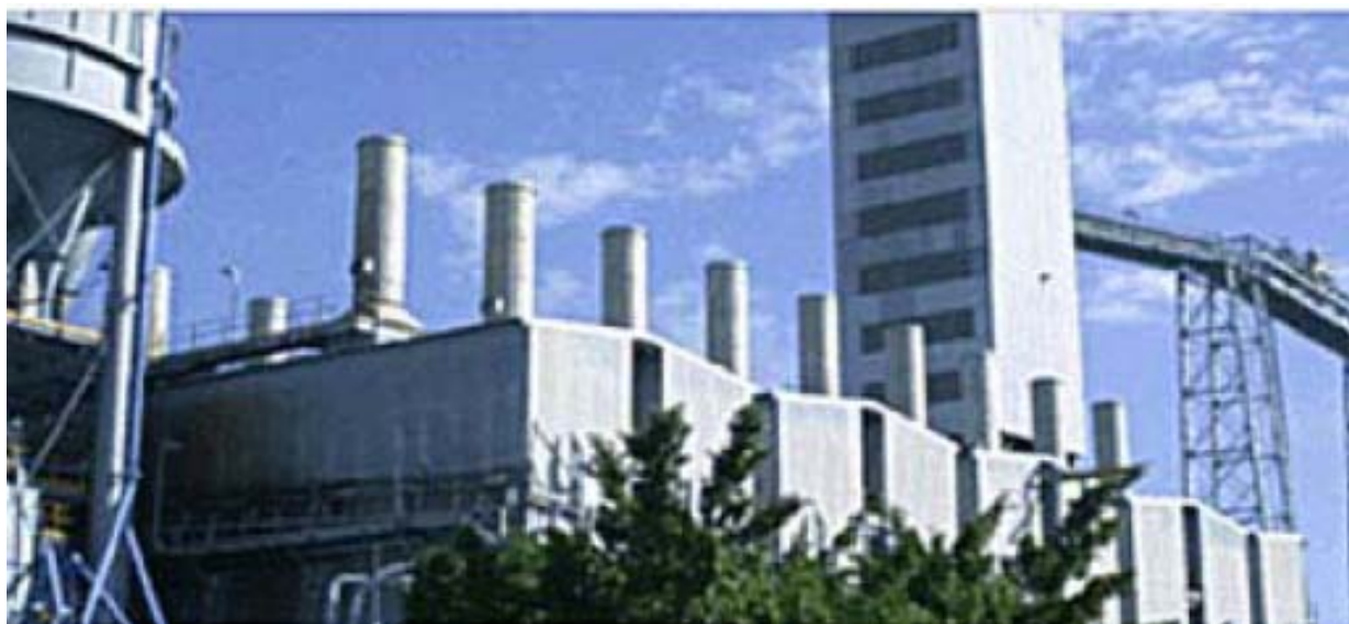
Fig. 3.1 - Exemplo de lavadores de gases a seco, com leito fluidizado de alumina
