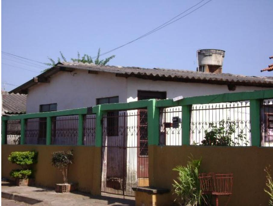
**Figura 5: Foto do telhado de cimento amianto – Goiânia-GO.**
