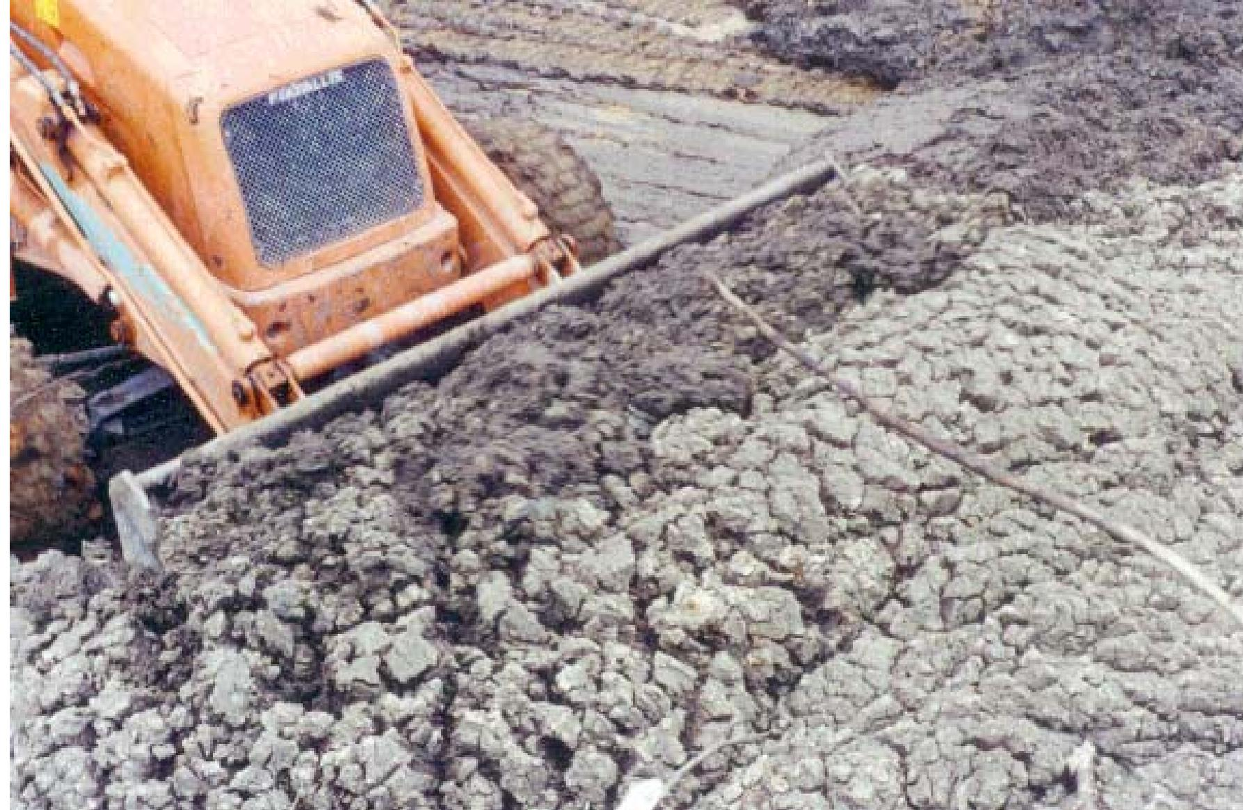
Foto 21. A armazenagem e manuseio a campo dos “Lodos Classe B” eram difíceis (lodo calcados da Sanepar ETE Belém). Infraero, Novembro / 2002.
