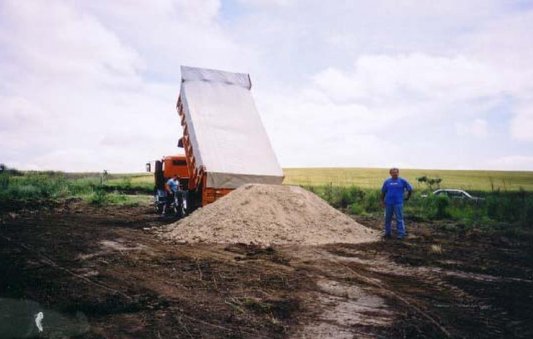
Figura 53. Outra vantagem do Processo N-Viro é a facilidade com que seu produto final N-Viro Soil (“Lodo Classe A”) é carregado, descarregado e armazenado nas áreas agrícolas. Fazenda Baronesa. Palmeira PR. Outubro / 03.
