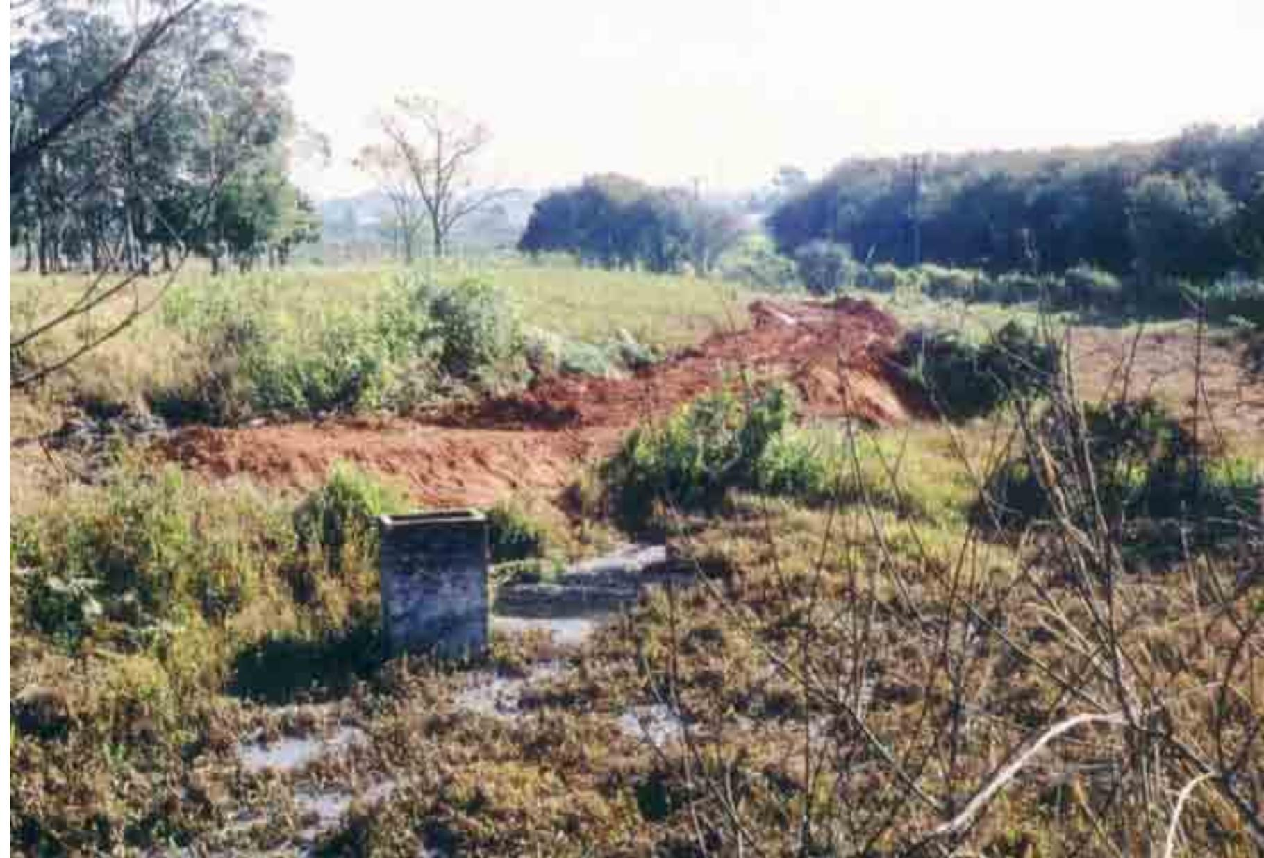
Figura 11. Necessita-se investir na manutenção das barragens de terra para se permitir a contenção dos lodos de esgoto nas lagoas.
