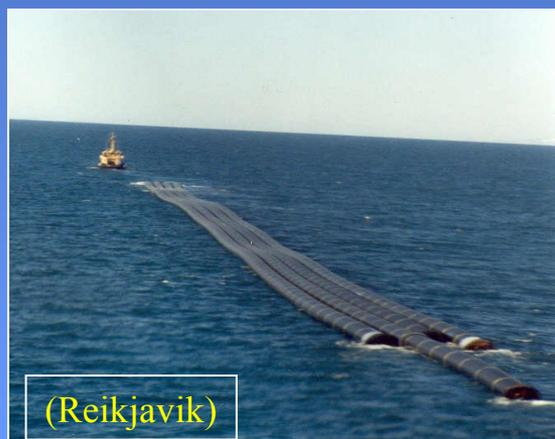
Montagem na superfície com barcaça ou plataforma
