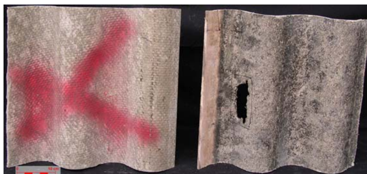
Foto 61 - Amostra Passarela Bloco da Química-QB (LPTR 854/05).
