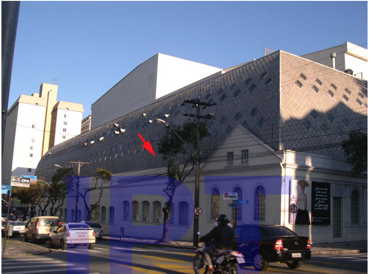
Foto 78 – Fachada do Shopping Center Mueller na Rua Cândido Abreu. A seta indica local selecionado para amostragem.
