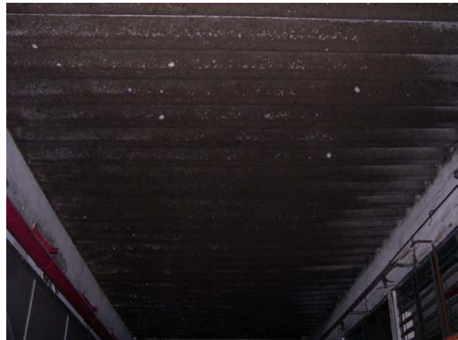
Foto 47 – Corredor interno do Pavilhão de recebimento. Os pontos brancos na telha correspondem provavelmente a material biológico.
