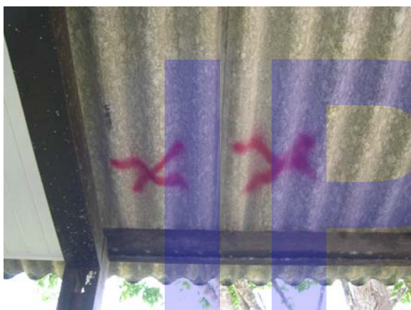
Foto 58 - Bloco PB Sala P1, na UFPA.
