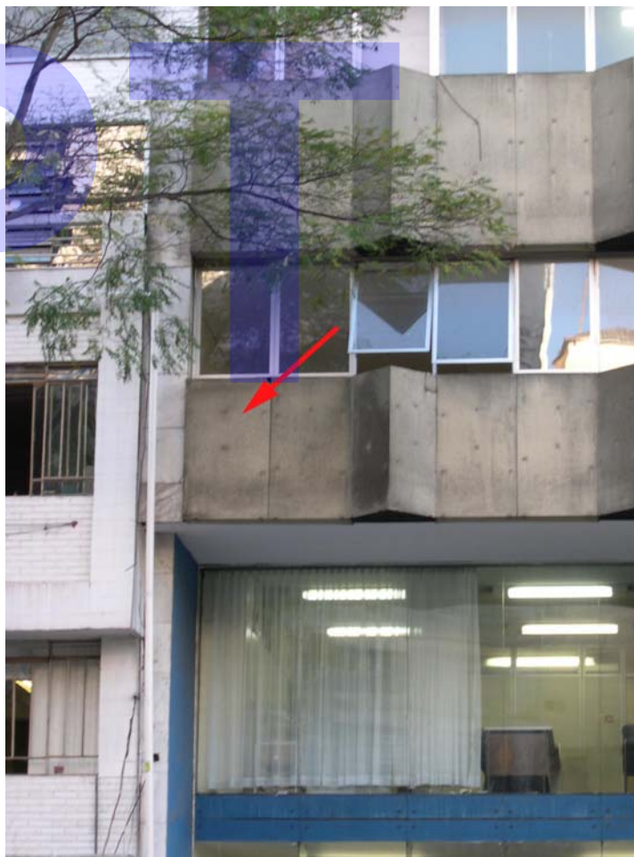
Foto 76 – Detalhe da FOTO anterior, com a seta indicando a placa cimentícia amostrada.
