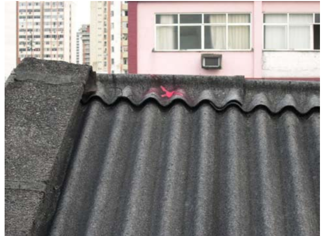
Foto 51 (acima) – Local de amostragem da cumeeira do setor de embalagens. O “X” vermelho indica o local amostrado.
