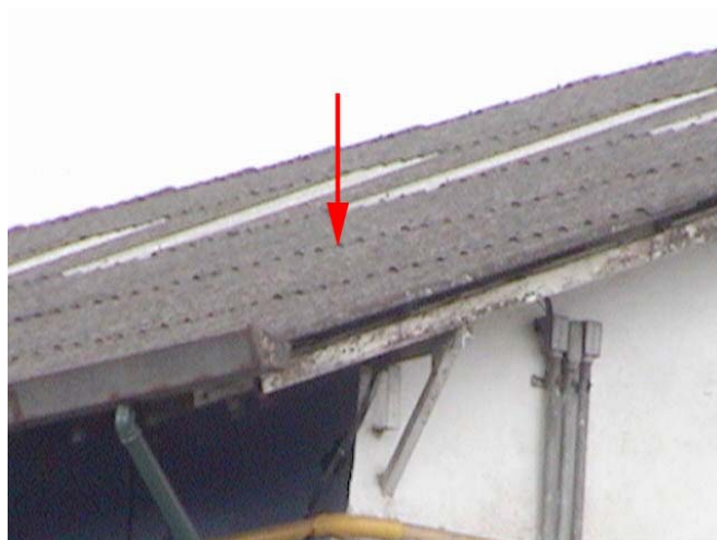
Foto 4 – Detalhe do local selecionado para a amostra de telha, na FOTO 2.
