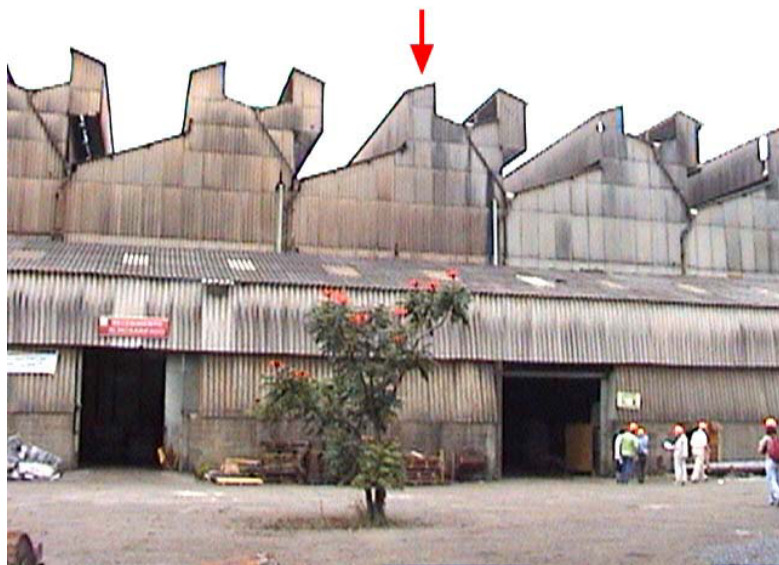
Foto 13 – Pavilhão da Forjaria, destacando-se o local de coleta da amostra de telha.
