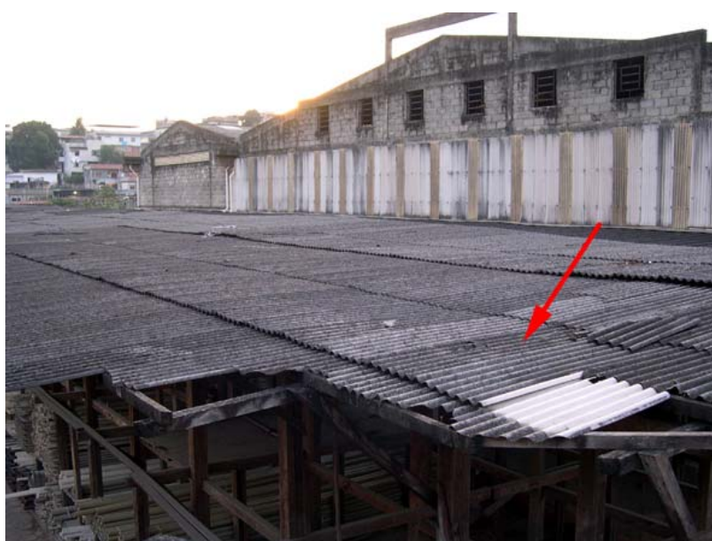
Foto 30 – Telhado do Depósito Manuel Crespum, em visada para oeste, ao final do dia. A seta indica local selecionado para amostragem.
