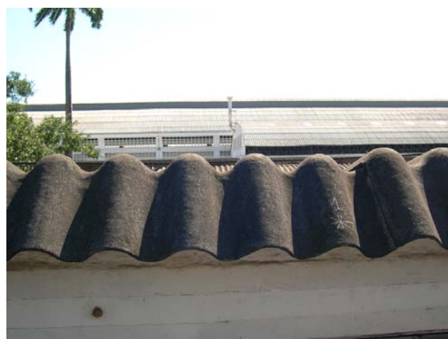
Foto 26 – Cumeeira selecionada para amostragem, no telhado do refeitório da Eternit.
