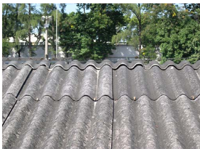
Foto 25 – Telha e cumeeira selecionadas para amostragem, no telhado do refeitório da Eternit.
