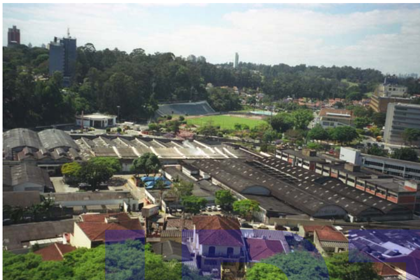
Foto 1 - Vista da região de Osasco. Destaca-se a indústria Adamas S.A., com cobertura de telhas de cimento-amianto.
