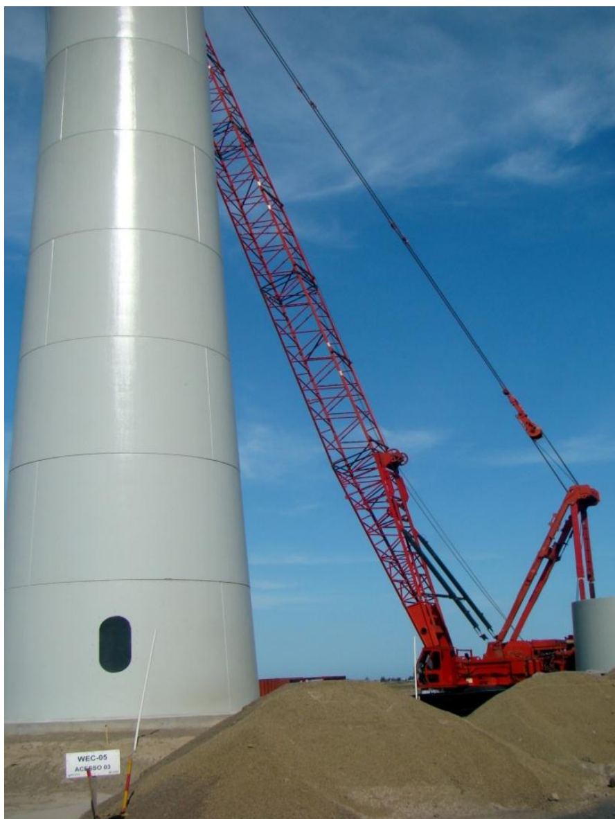
Figura 28: Vista lateral da construção da torre eólica com auxílio de grua
