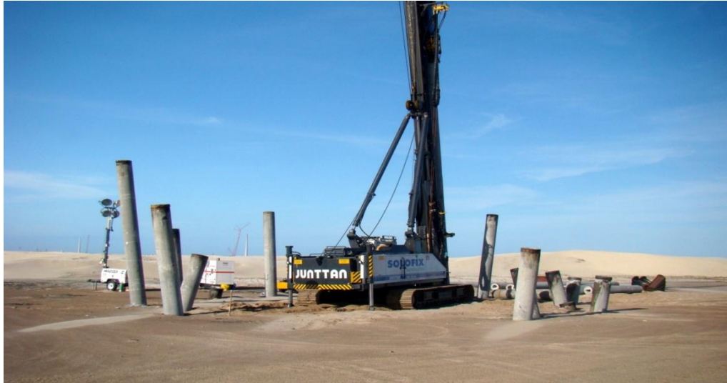
Figura 19: Fundação de torre eólica com estaca de concreto
