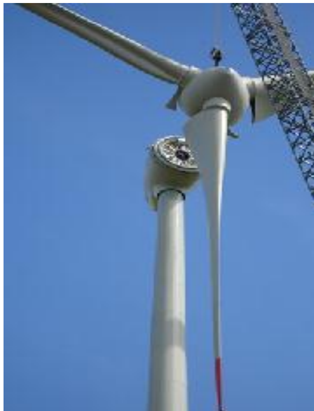
Figura 32: Acoplamento das partes anterior e posterior da nacele
