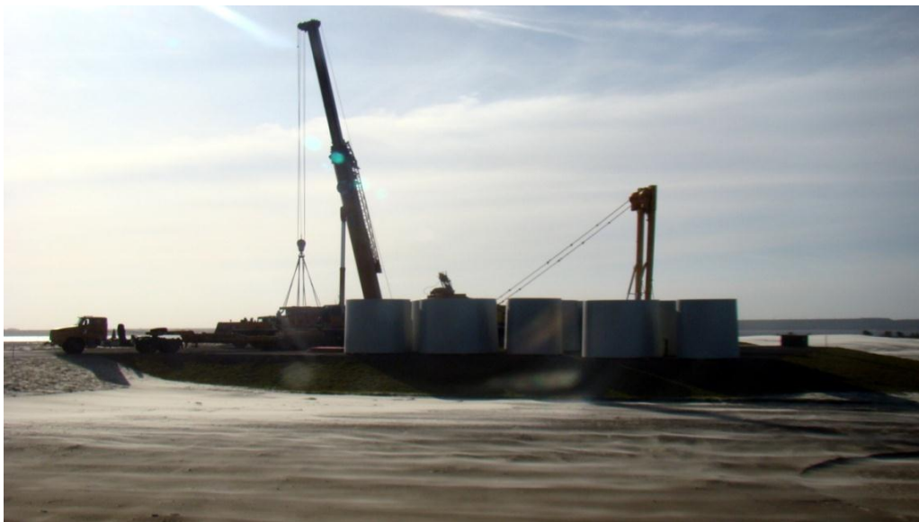
Figura 25: Peças de encaixe para edificação da torre eólica
