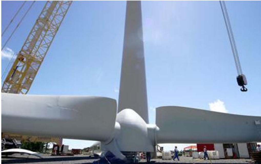
Figura 31: Montagem das pás na parte anterior da nacele
