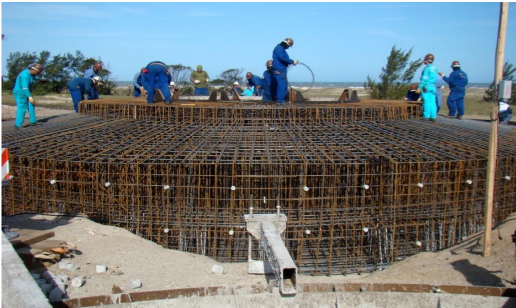
Figura 21: Armação de estrutura do bloco de coroamento de torre eólica - vista lateral
