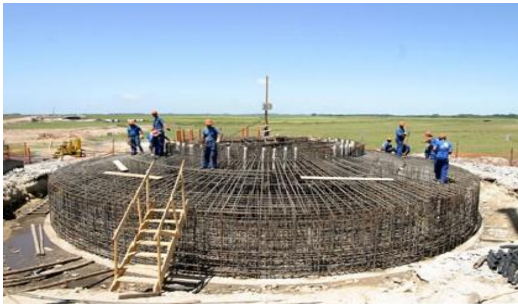
Figura 22: Armação de estrutura do bloco de coroamento de torre eólica - vista superior
