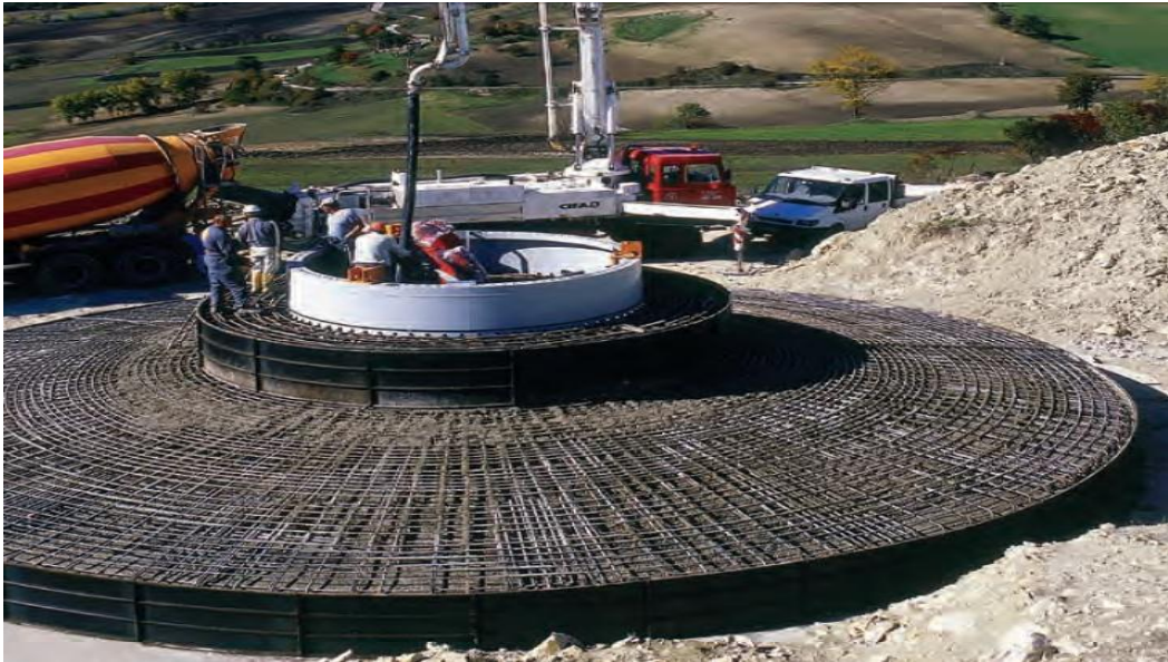
Figura 24: Montagem do mastro na fundação
