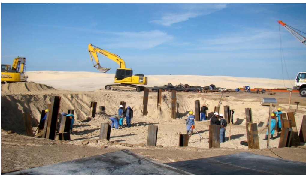
Figura 18: Fundação de torre de eólica com estaca metálica
