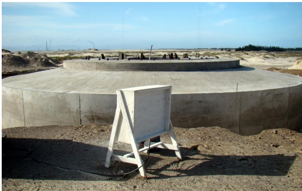
Figura 23: Concretização do bloco de coroamento de torre eólica - vista lateral
