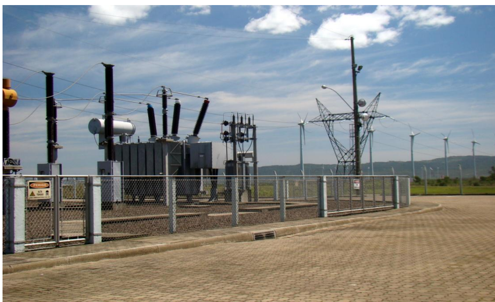
Figura 34: Interconexão da subestação com a linha de transmissão
