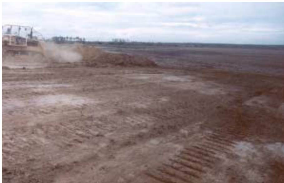
Figura 3.B.22 – Terraplenagem e soterramento de unidades de preservação permanente (lagoa sazonal e mata ciliar) para a implantação de uma fazenda de camarão nas proximidades da aldeia Passagem Rasa, comunidade indígena Tremembé (proximidade das coordenadas UTM E=404839 e N=9668844).
