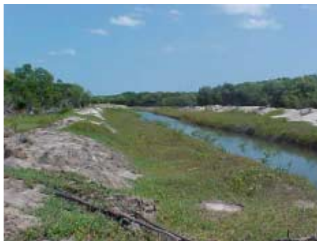
Fig D.3 – Canal escavado em manguezal.
