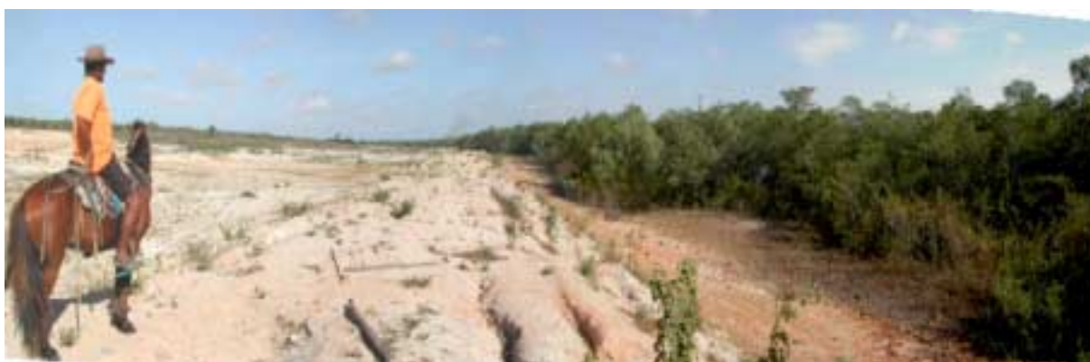
Figura 3.B.10 – Obras abandonadas para a implantação de uma fazenda de camarão. Verificar que foram edificadas em área de preservação permanente e associadas ao desmatamento do manguezal e do carnaubal. Sobre os taludes observou-se a presença de sulcos de erosão, com o material sedimentar assoreando o manguezal (setor nas proximidades das coordenadas UTM E= 450917 e N= 9648143).
