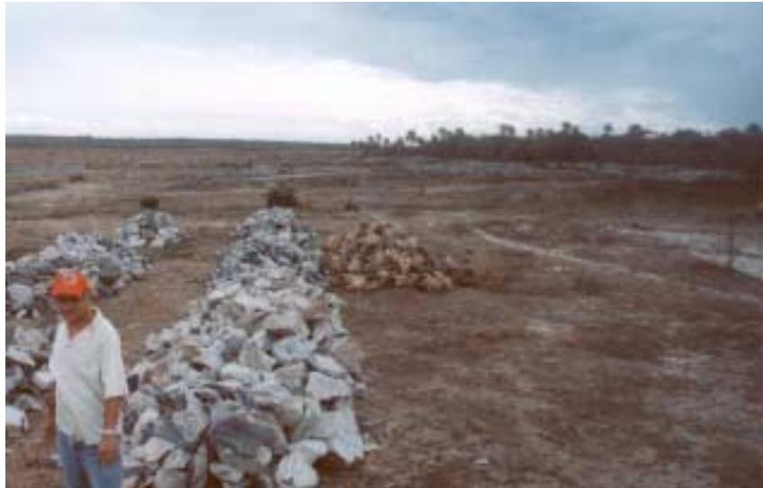
Figura 3.B.21 – Início das atividades da construção de viveiros de camarão em uma lagoa sazonal (denominada pelos índios Tremembé de lagamar), associada ao canal principal do rio Aracatimirim. Áreas úmidas de preservação permanente (APP). Para esta atividade foi também retirada a mata ciliar e manguezal nas proximidades do estuário (coordenadas UTM E=404839 e N=9668844).
