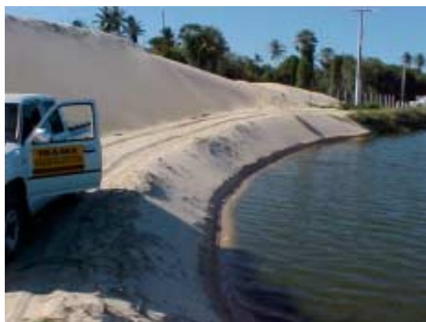
Fig. D.6 – Tanque de carcinicultura com interferência em duna.
