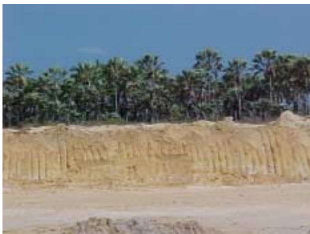
Fig. D.4 – Talude sendo construído em área anteriormente ocupada por carnaubal.
