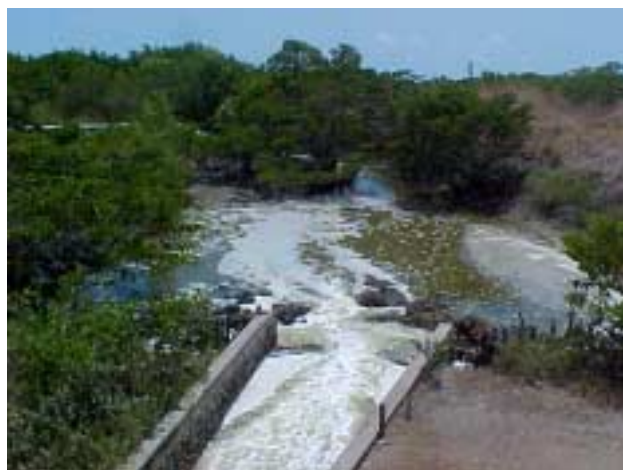
Figura F.4 – Empreendimento com descarte de efluentes sem prévio tratamento diretamente no manguezal, no Litoral Leste.
