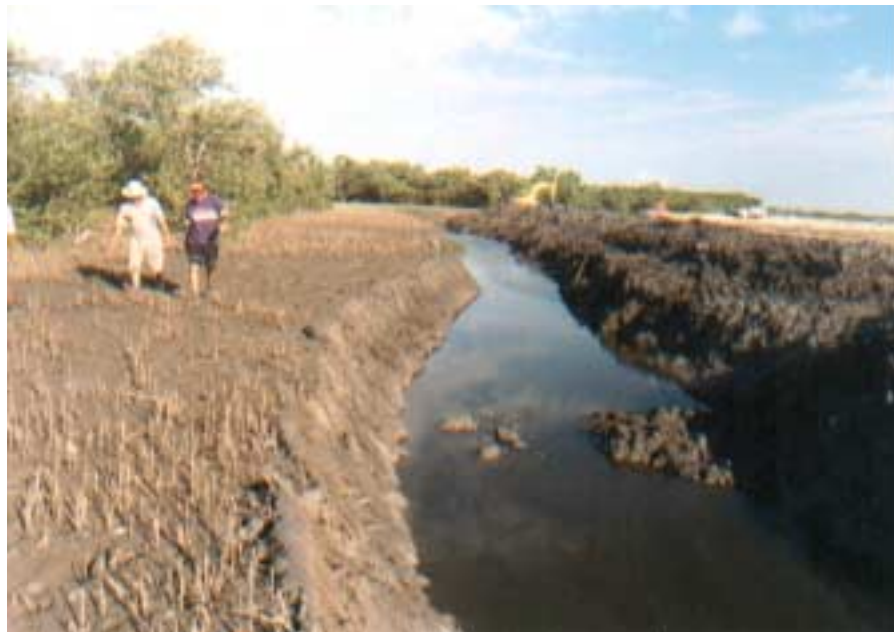
Figura 3.B.16 - Fundações para a construção de diques para a implantação de viveiros de camarão sobre uma área de vegetação de mangue que foi desmatada ao longo do ecossistema manguezal do rio Acaraú. Verificar o sistema radicular com pneumatóforos (raízes respiratórias que se projetam para fora do solo) denunciando intervenções inadequadas em uma APP. Os viveiros de camarão estão ocupando áreas antes destinadas ao controle da vazão fluvial durante os eventos de cheias, o que certamente provocará mudanças na dinâmica fluvial e a origem de áreas de riscos de enchentes e inundações (Coordenadas UTM E=379345 e N=9686925)
