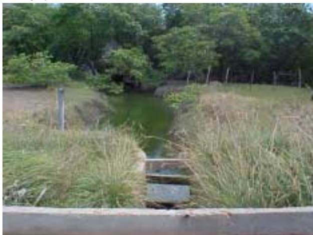
Figura F.5 – Empreendimento com descarte de efluentes sem prévio tratamento diretamente no manguezal, no Litoral Leste.
