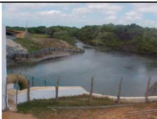
Fig. E.6 – Canal escavado para aproximar água do rio/gamboa à casa de bombas, em Acaraú.
