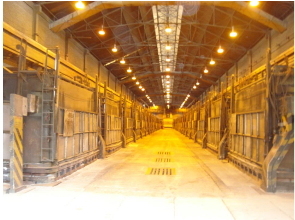
Sala de cubas de pinos horizontais - HSS
