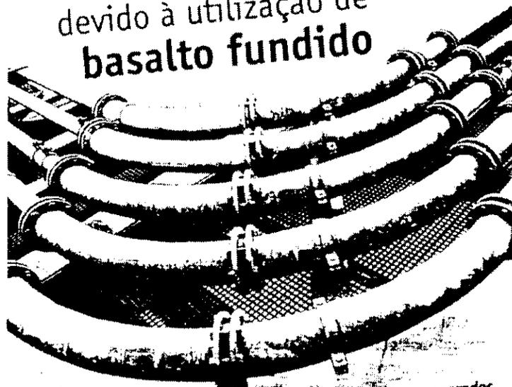
O basalto fundido ABRESIST é um dos materiais mais consagrados para proteção antidesgaste. Mais de um milhão de metros de tubulação já foram revestidos pela Kalenborn com basalto fundido ABRESIST.
