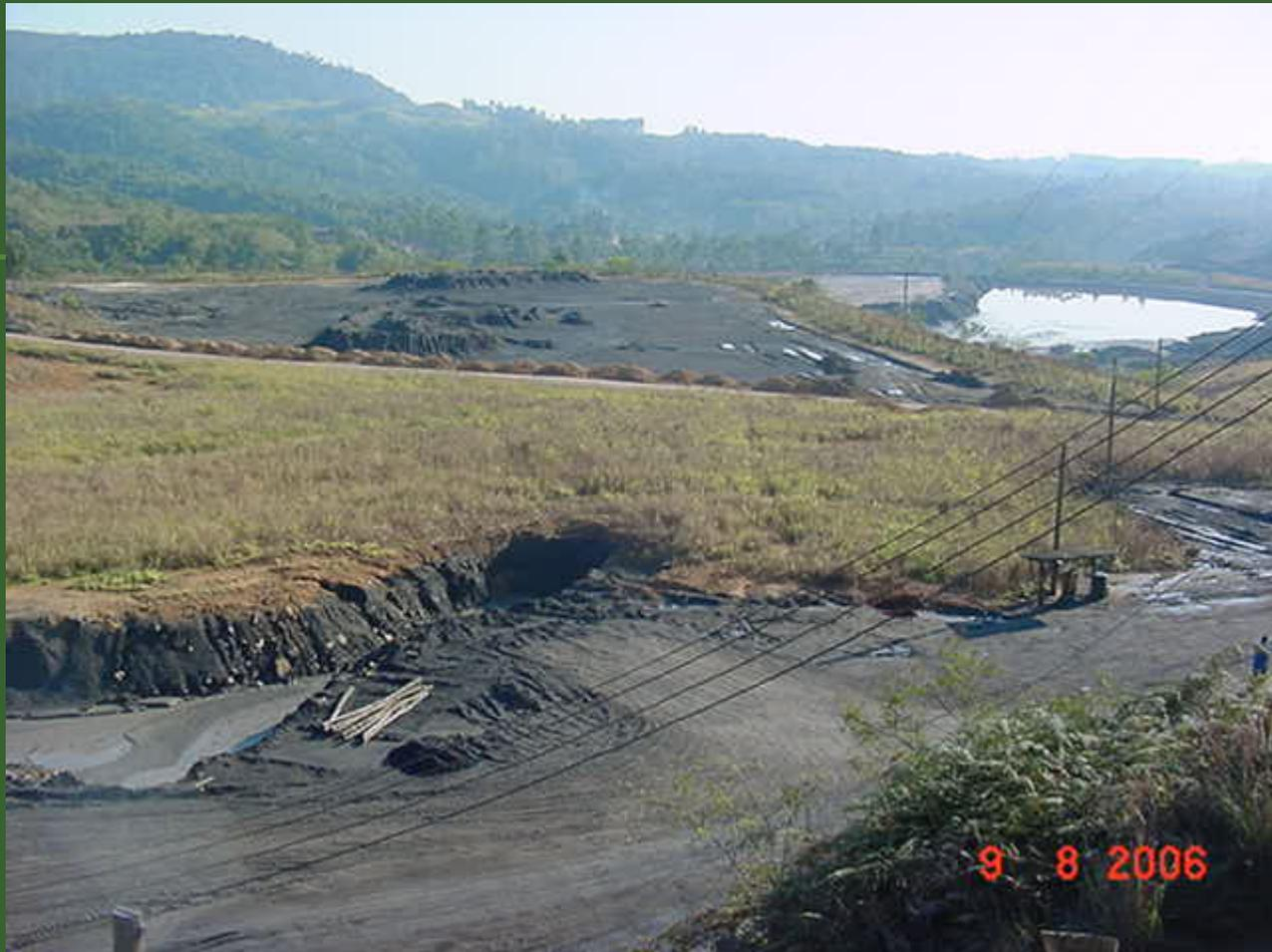
Comin relavando rejeito da mina Rio América. Depósito de finas da relavagem do carvão, bacia de decantação em circuito fechado não permeabilizada e área coberta com argila sem impermeabilização lateral ou inferior.
